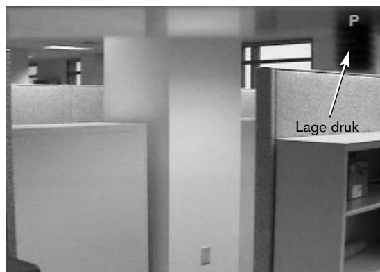
Foto 7D Alarmmelding 'Onderdruk' blijft actief
