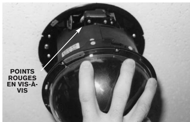
Photo 2F Insertion du bloc caméra
